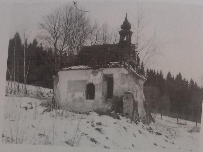
Obr. 14: Kaple sv. Barbory v Podlesí Stav r. 1992
